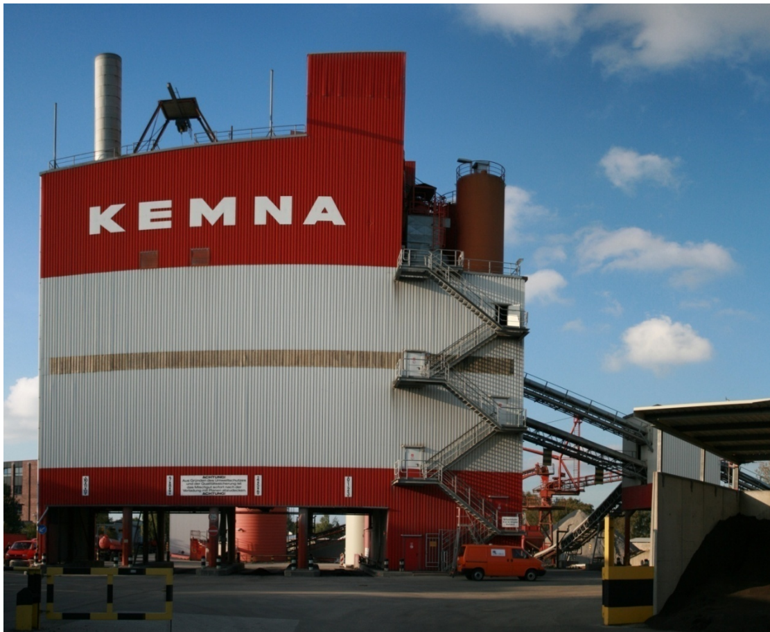
Bild 1: Ansicht des Asphaltmischwerkes der Firma Kemna Bau Andreae GmbH & Co. KG in Hamburg Altona. In der oberen, linken Bildhälfte ist der Abzug, an dem die Emissionsmessungen durchgeführt wurden, erkennbar.
