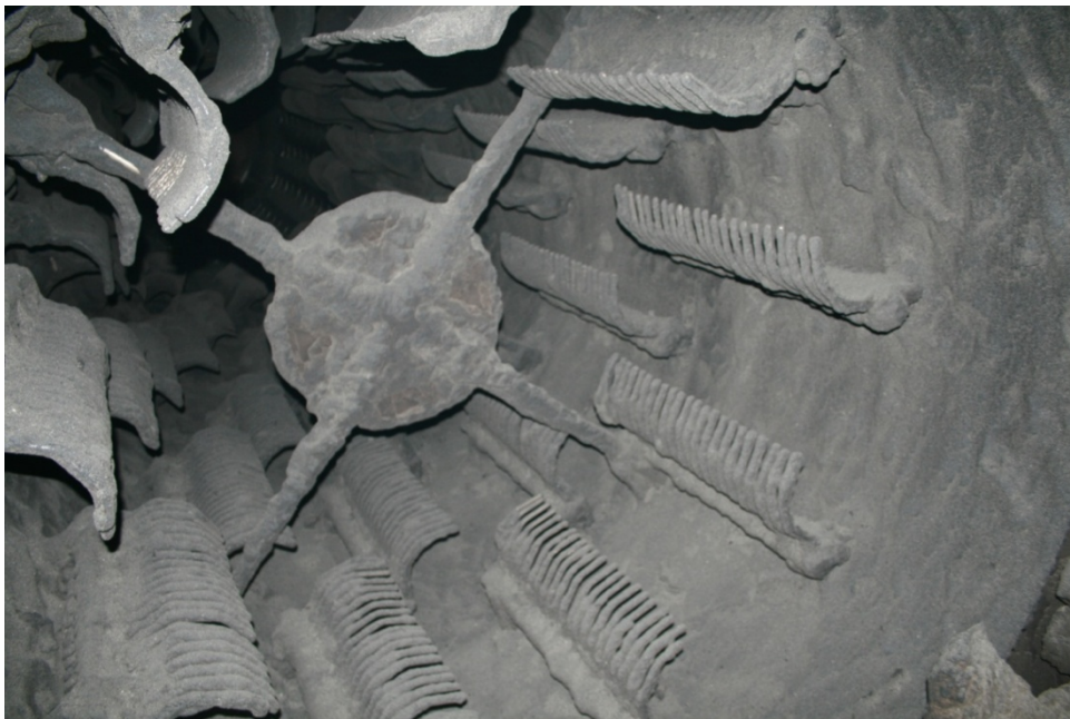
Bild 5: Ansicht in die Paralleltrommel von der dem Flammeneinlass gegenüberliegenden Seite während des Stillstands der Anlage am Vortag der Emissionsmessung. An der Innenwand sind die versetzt angeordneten Rechen zur Homogenisierung des Asphaltgranulats erkennbar.
